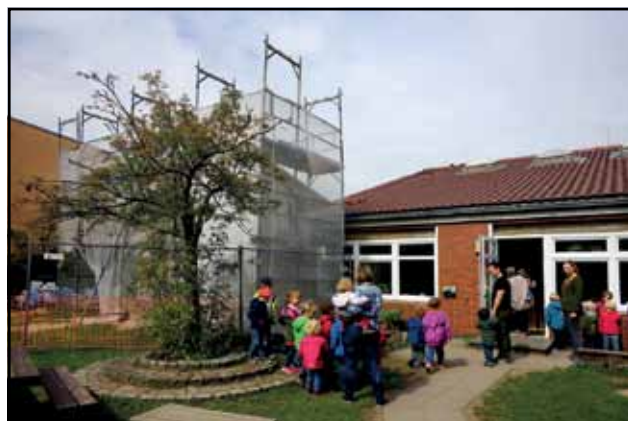
Neue Räume werden angebaut, es sieht allerdings
